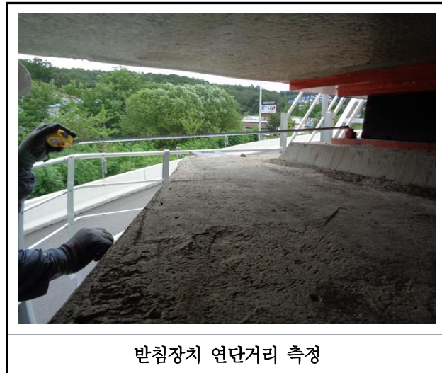
【사진 41.3.12】 교량받침장치 연단거리측정
