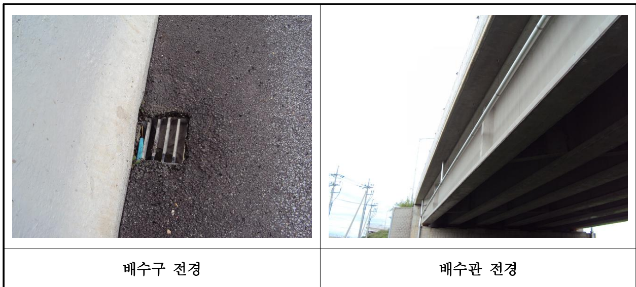
【사진 41.3.19】 배수시설 전경
