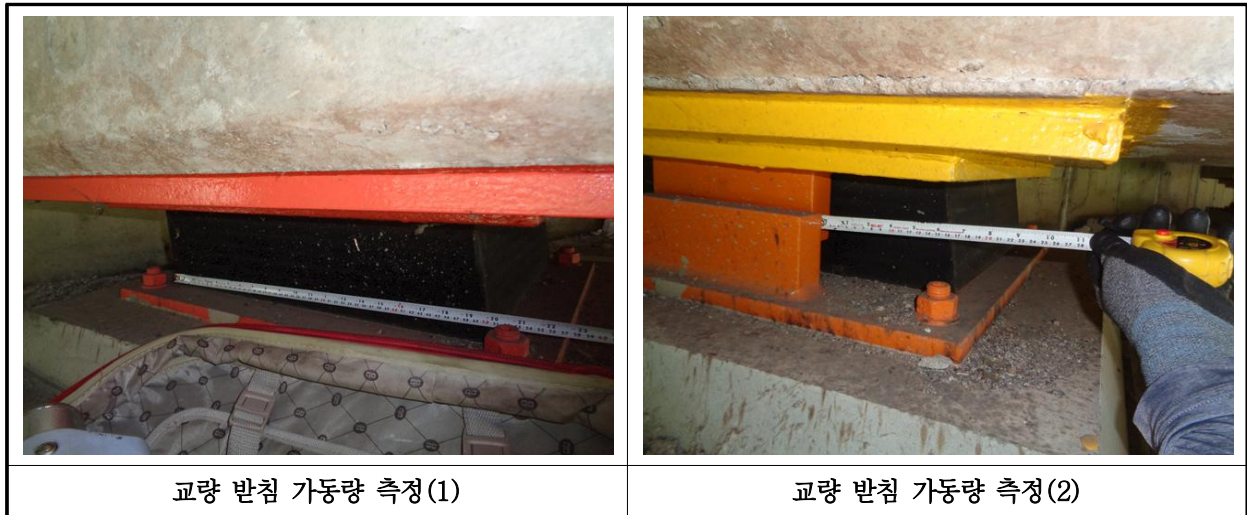
【사진 41.3.13】 교량받침 이동량 측정
