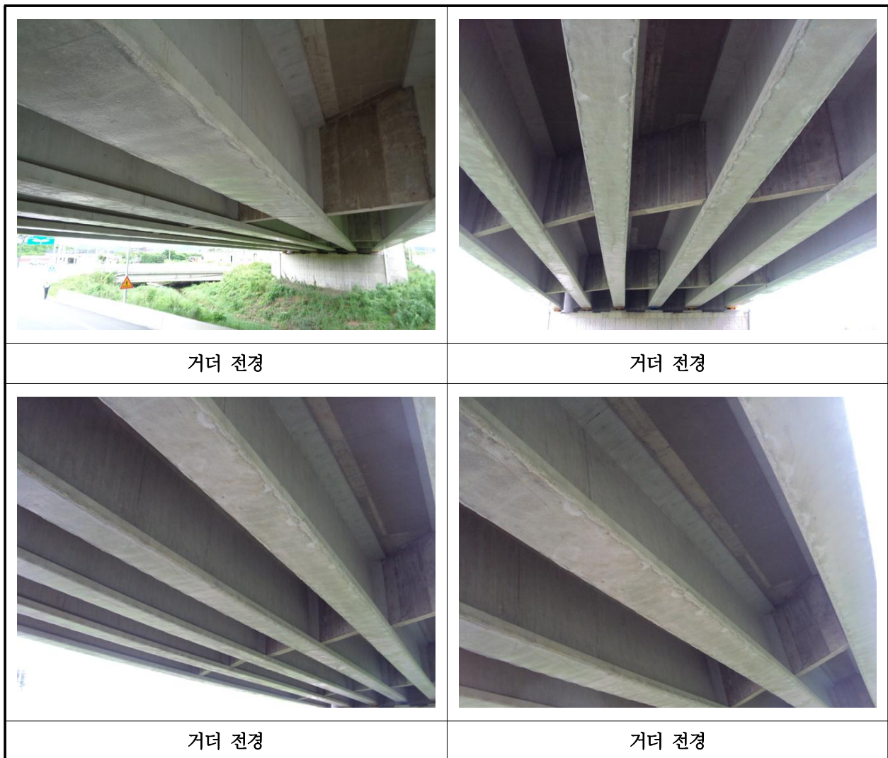
【사진 41.3.4】 거더 전경
