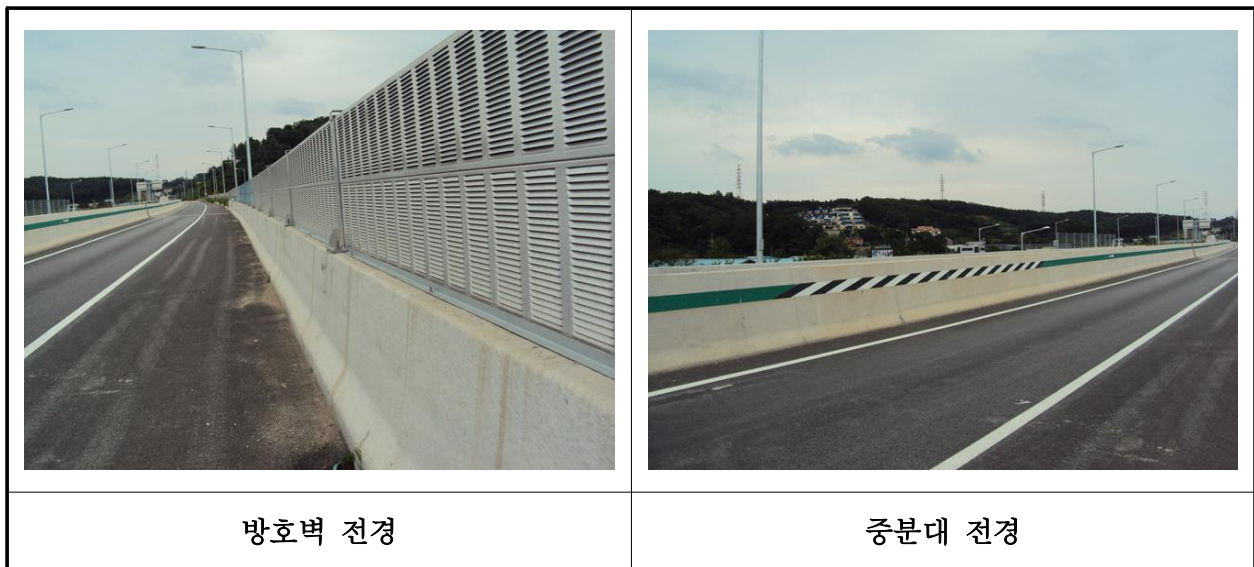
【사진 41.3.21】 방호벽 및 중앙분리대 전경
