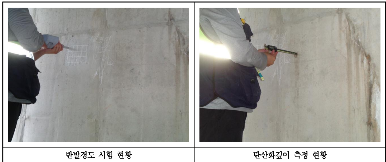
【표 41.4.1】 콘크리트 내구성조사 현황
