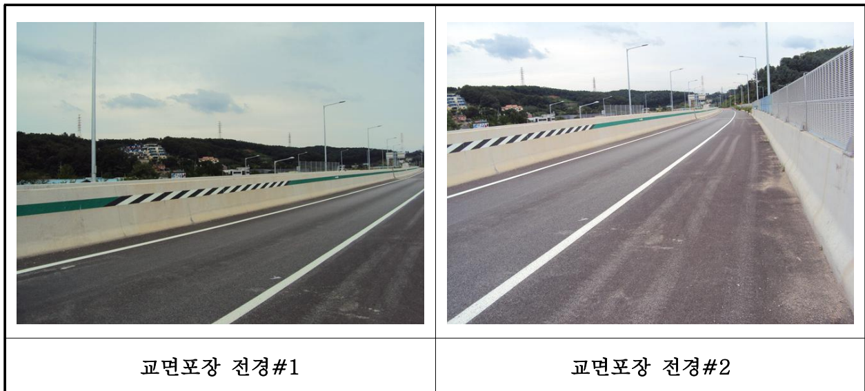
【사진 41.3.17】 교면포장 전경
