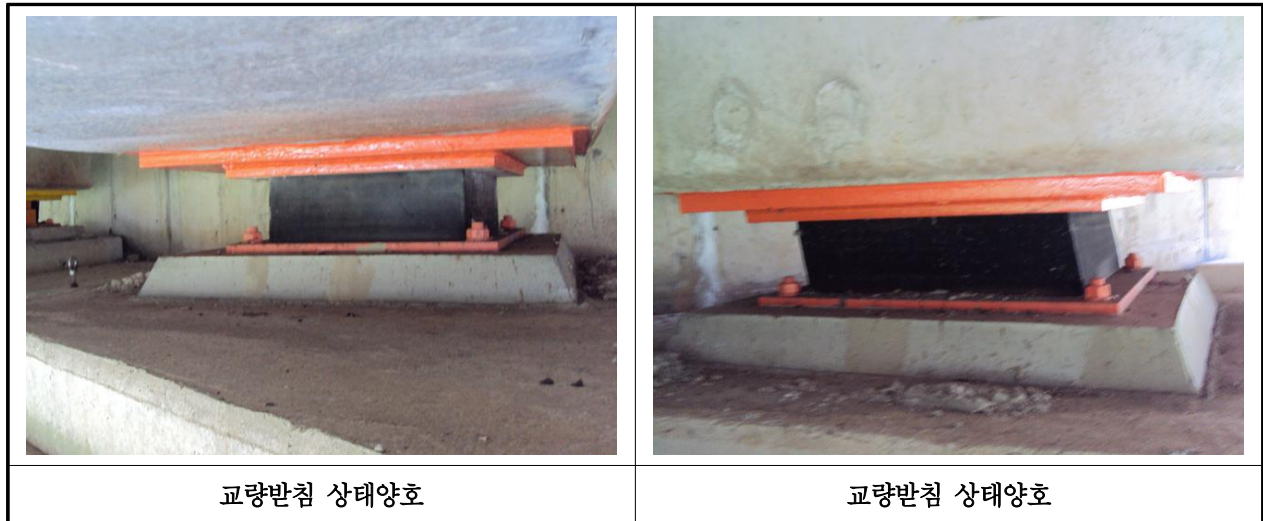
【사진 41.3.11】 교량받침 손상현황
